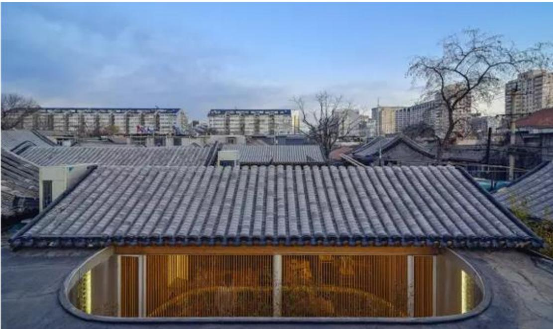
根据房屋的年代和使用价值，设计采取选择性的修复方式：北房以保持历史原貌为主，仅对破损严重的地方做局部修补，替换残缺的砖块。
