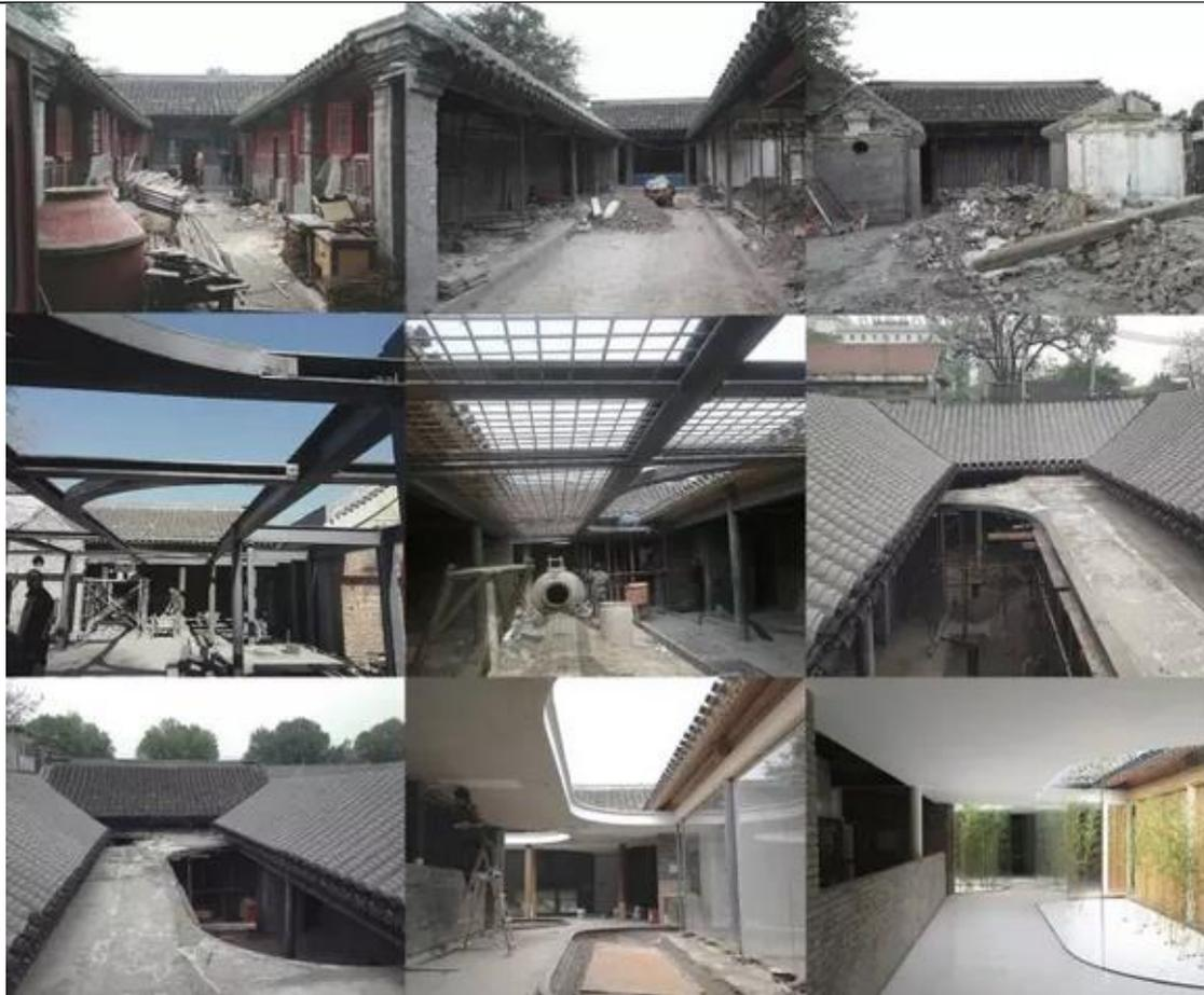
同时，把建筑中的流线视觉化，转化为“廊”的形式，在旧有建筑的屋檐下加入一个扁平的“曲廊”将分散的建筑合为一体，创造新旧交替、内外穿越的环境感受，新与旧相互产生对话。
